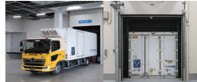
施設開口部と車両の隙間からの外気侵入を防ぐドックシェルター
