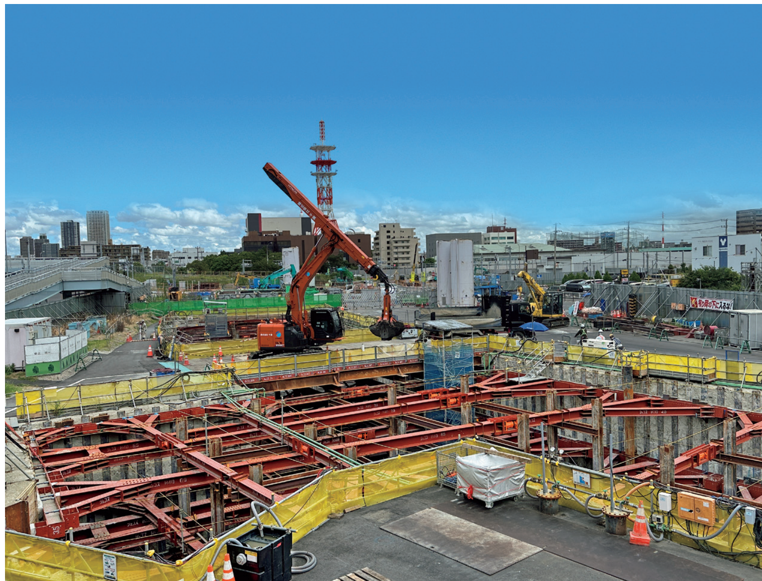
東京外環自動車道 京葉ジャンクションGランプ工事
