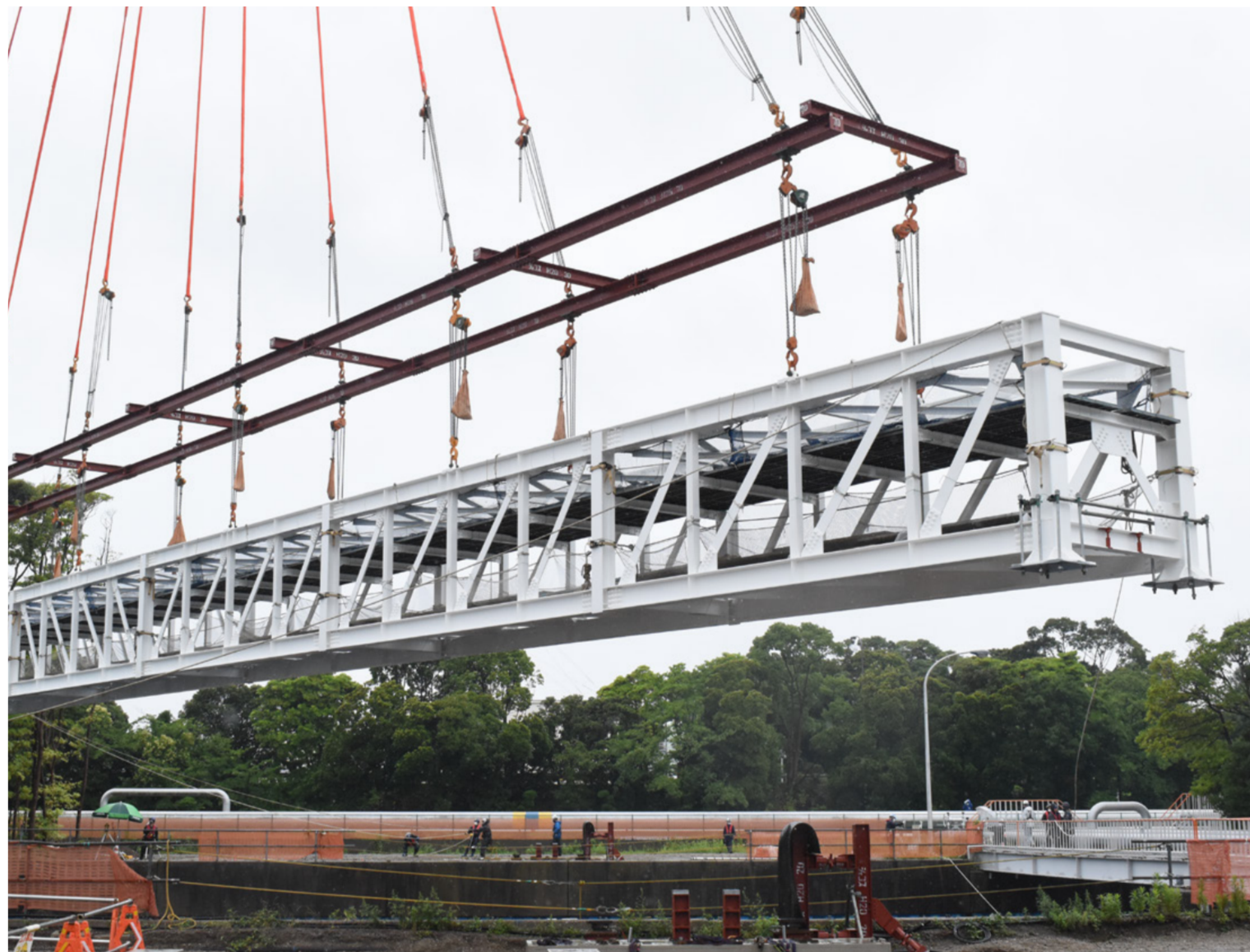
当社長沼工場で製作、一括架設したトラス配管橋
