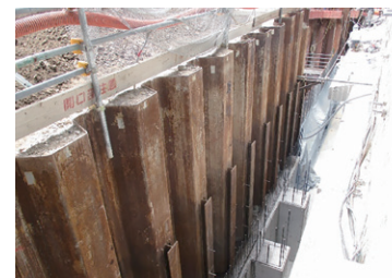
地下壁施工状況
