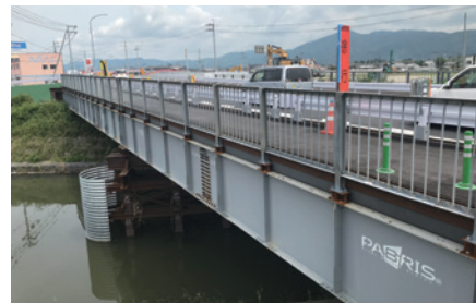
仮設橋梁「PABRIS®」
